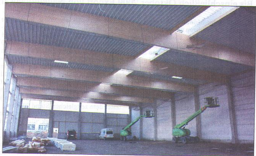
In der neuen Halle sind Lager, Kommissionierung und Verladung zusammengeführt
